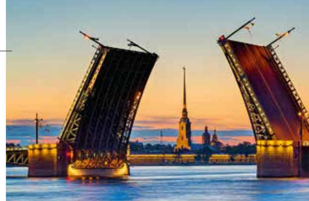
Масса противовесов Дворцового моста – 2800 тонн. При разводке они опускаются в котлованы в глубину два метра
