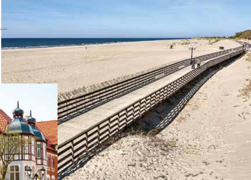
Деревянный променада в Янтарном. Для строительства использовалась сибирская лиственница. Она наиболее устойчива к гниению
