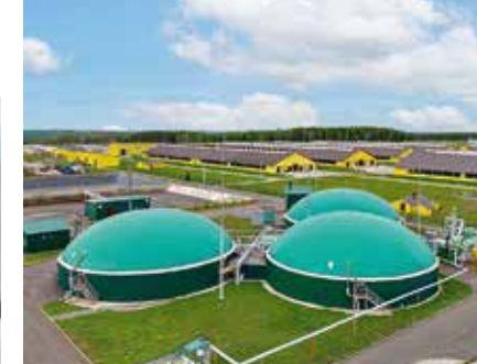
Биогазовая установка, работающая на отходах животноводства, пгт Актюбинский
